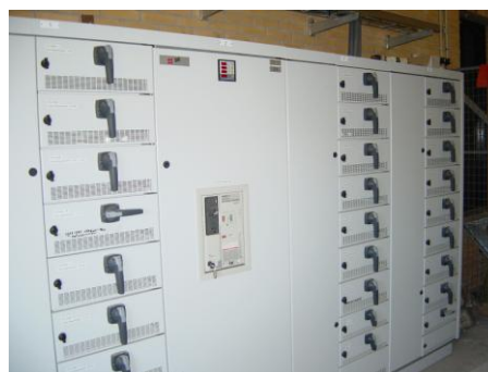
Foto 2: Met een cos phi verberteraar of blindstroombatterij kon meer vermogen worden geleverd door dezelfde verdeelkast.
